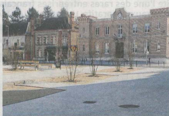
La place centrale de la commune a été entièrement réhabilitée. Les travaux se sont terminés mi-2013.
